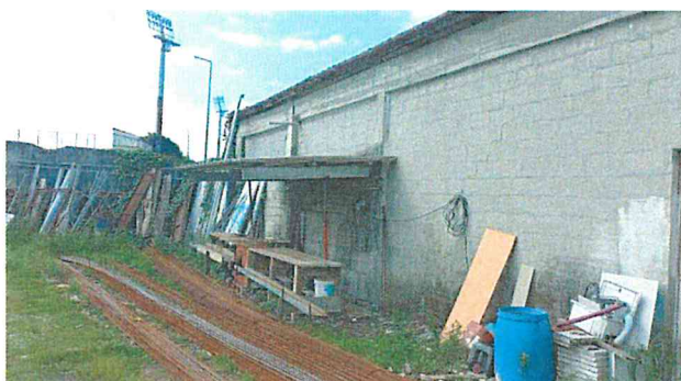
Fotografia n.º 5 - Logradouro (Estaleiro de ferro)
