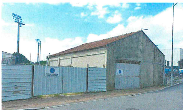
Fotografia n.º 1 – Alçado principal do edifício
