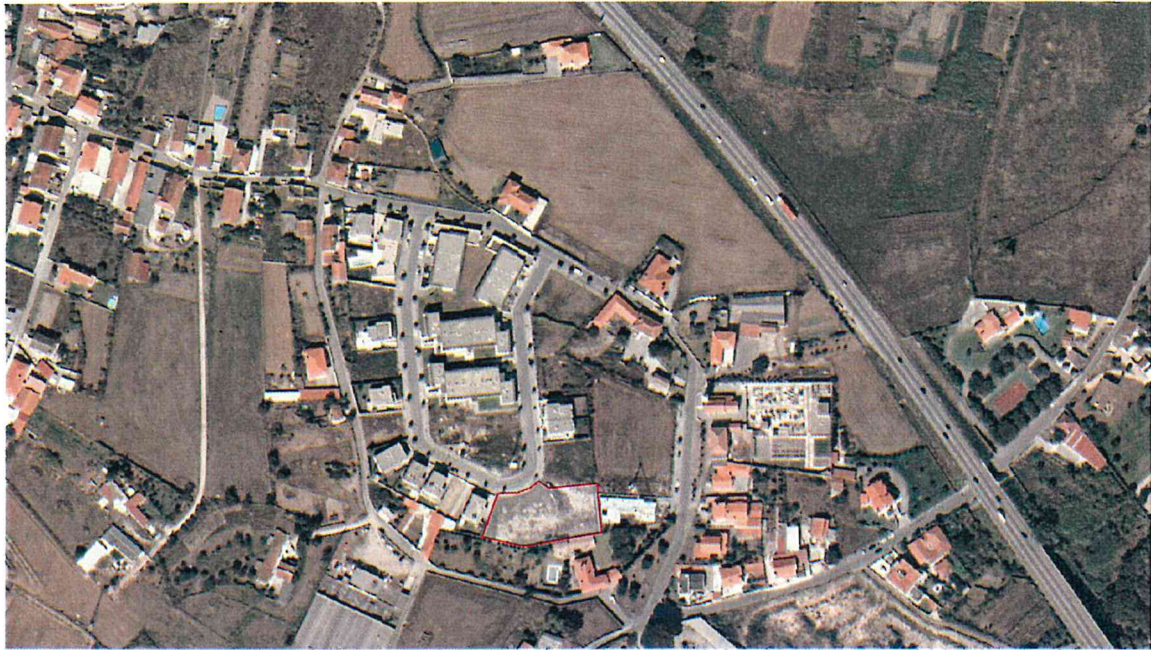
Fig. 1: Vista aérea do prédio (assinalado a vermelho)
