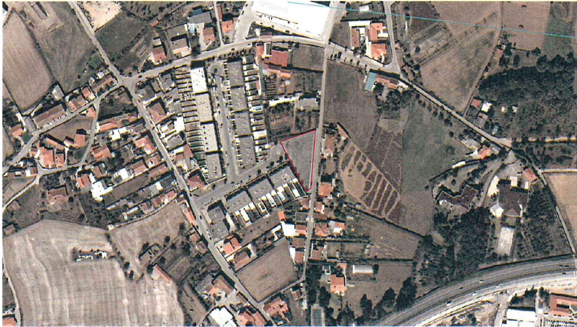
Fig. 1: Vista aérea do prédio (assinalado a vermelho)
