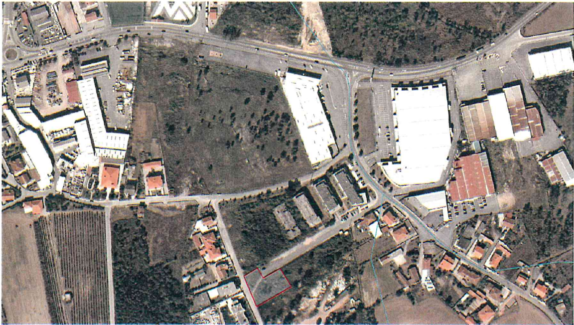
Fig. 1: Vista aérea do prédio (assinalado a vermelho)
